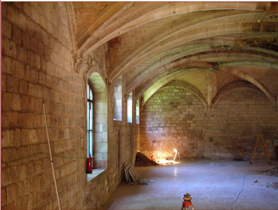
Foto 6. Procés d'excavació del sondeig 2.
