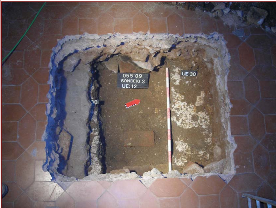
Foto 12. Vista del paviment de calç UE 30, un cop excavada la rasa constructiva UE 12 de la claveguera UE 06. Sondeig 3.
