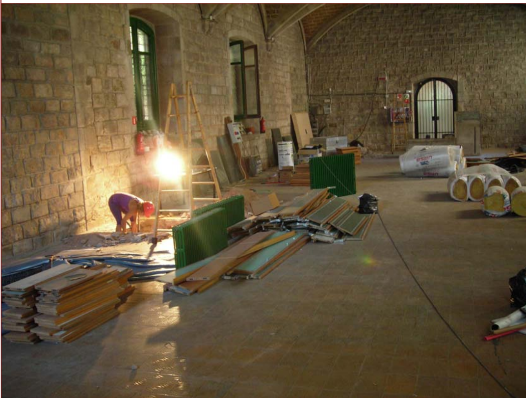
Foto 16. Procés d'excavació del sondeig 4.
